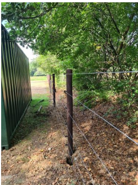
Afbeelding 5 en 6: Vaste wolfwerende afrastering
