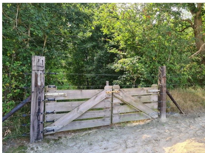
Afbeelding 5 en 6: Vaste wolfwerende afrastering
